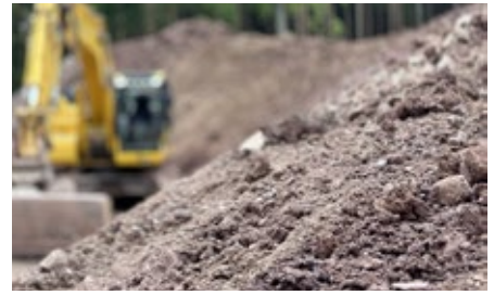
Sechs Meter tief wurde die Baugrube ausgebaggert, dafür rund 1.200 Kubikmeter Material (ca. 3.000 t) ans Tageslicht befördert. Noch erinnert ein gigantischer Abraumberg (Foto r.) an diese Mammutaufgabe.
