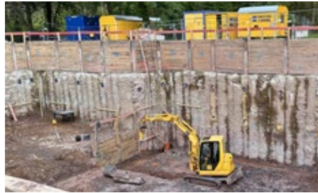
Sechs Meter tief wurde die Baugrube ausgebaggert, dafür rund 1.200 Kubikmeter Material (ca. 3.000 t) ans Tageslicht befördert. Noch erinnert ein gigantischer Abraumberg (Foto r.) an diese Mammutaufgabe.
